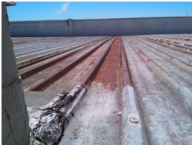
Estado de la chapa de sobretecho
